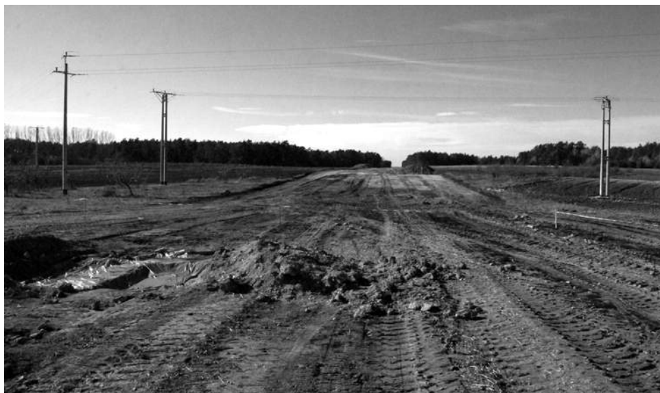
Widok na pas drogowy budowanej drogi w październiku 2013 r., pośrodku widoczne wykopy po wyeksplorowanych grobach, fot. H. Mącik.
